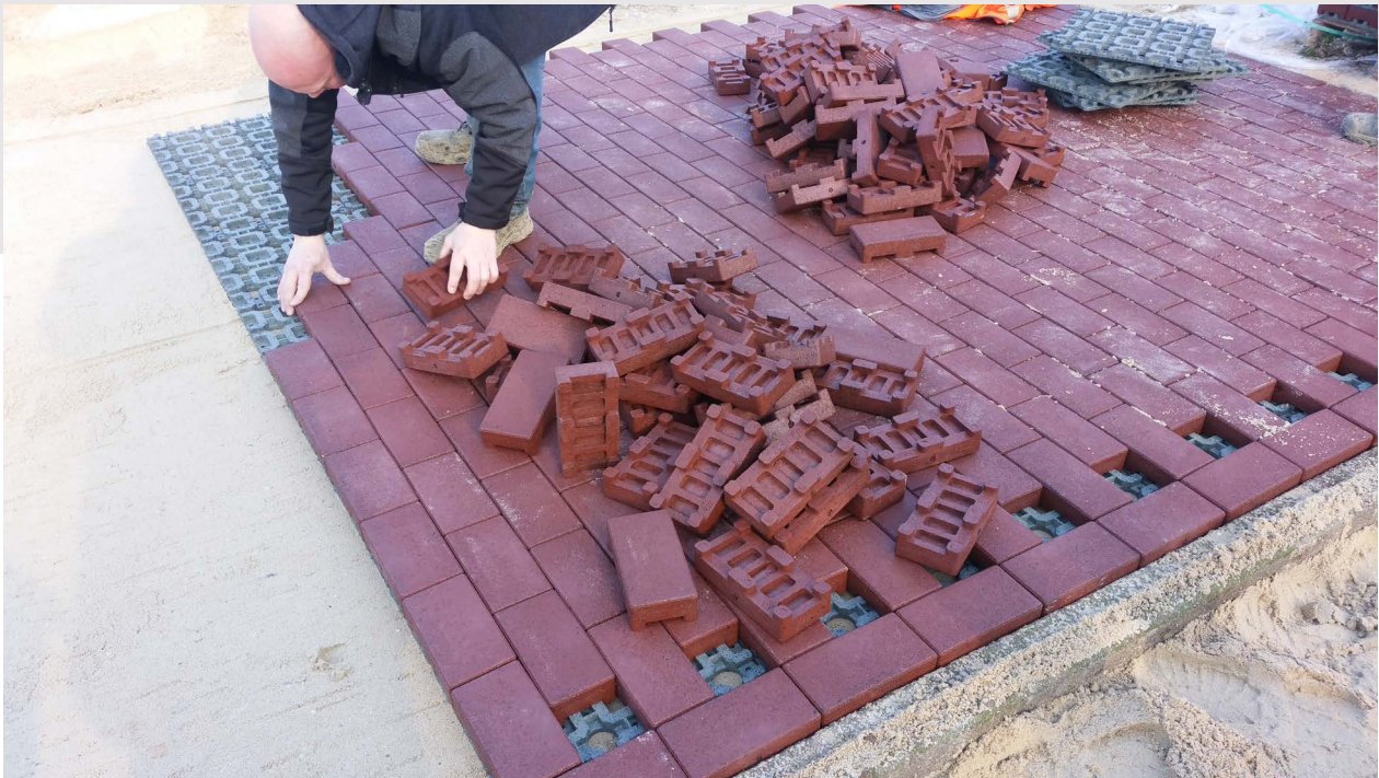
Afbeelding 1. Leggen van de kunststof klinkers op het onderliggende rooster.
